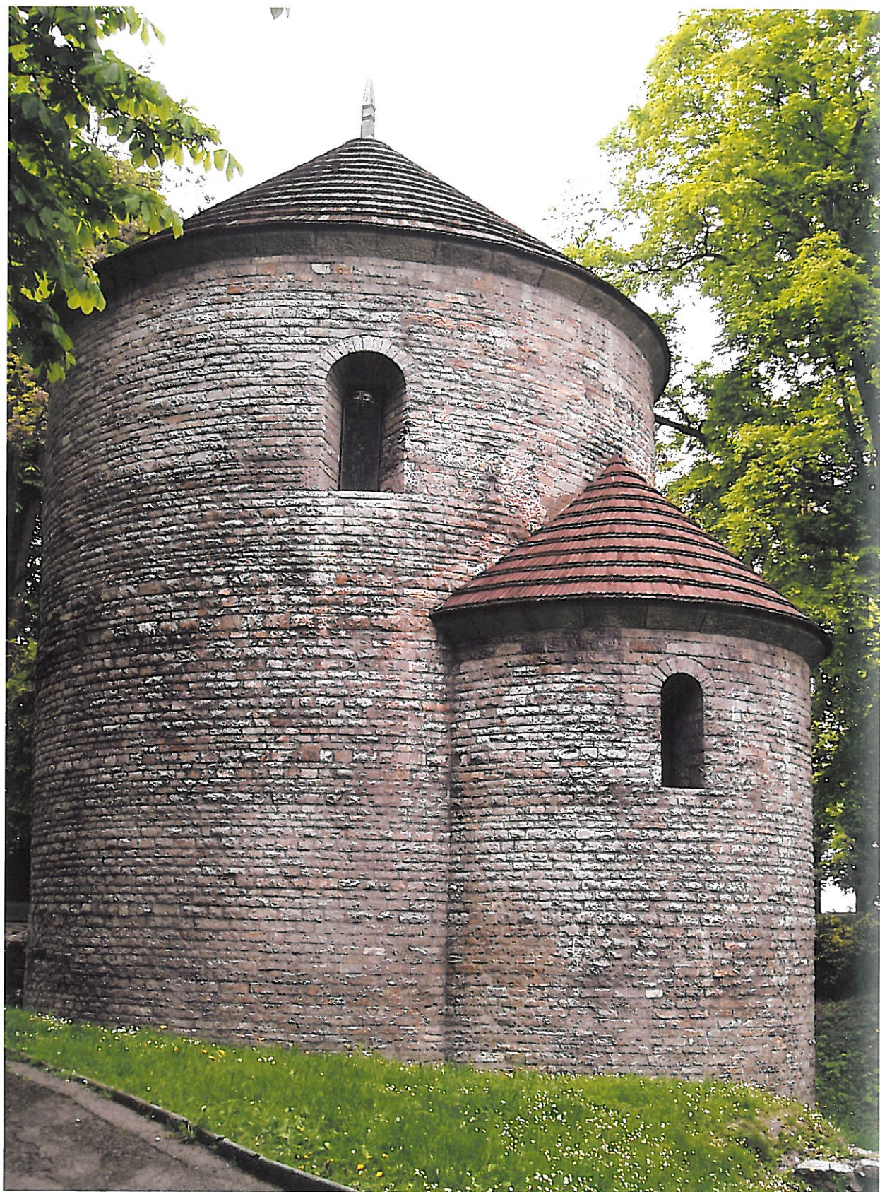
Rotunda w Cieszynie, XI wiek. Średnica nawy 6,4 m, wysokość do podstawy sklepienia 11,3 m.
